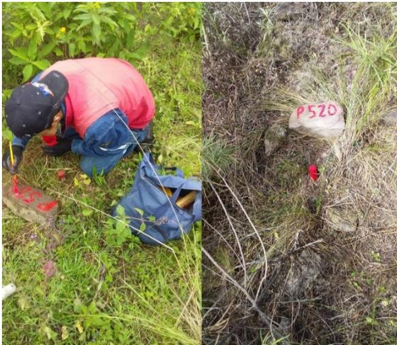
**Figura 4.** Marcado de puntos para plantado de postes de línea eléctrica
