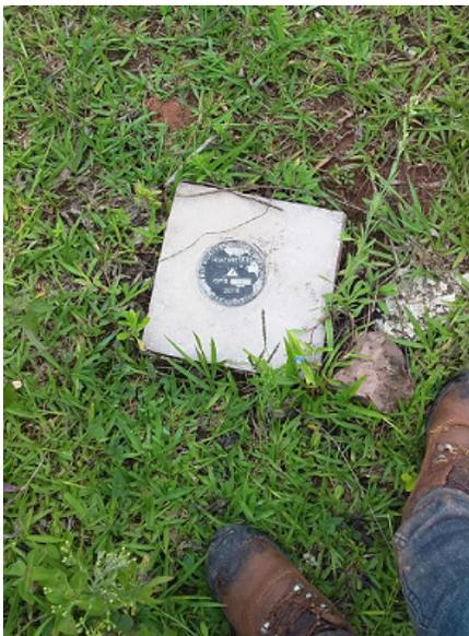
**Figura 2.** Plaqueta metálica en mojón de concreto
