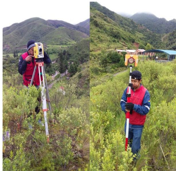
**Figura 3.** Diseño LMT y BT con estación total
