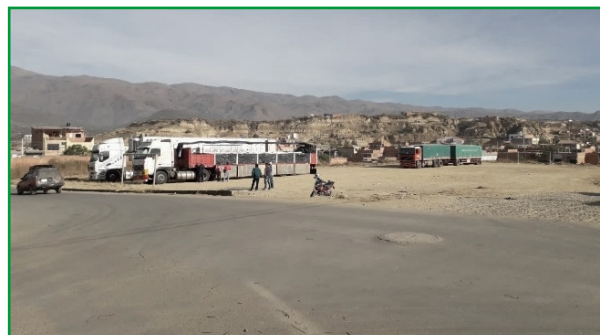
Fig. 2. Área destinada para recreación y ocio, ocupada por Transporte pesado para el servicio mecánico, se puede observar la degradación del espacio público y su entorno.
