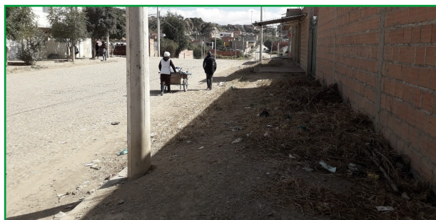
Fig. 5. Se puede observar que la falta de consolidación de aceras obliga al peatón a desplazarse sobre la vía vehicular.
