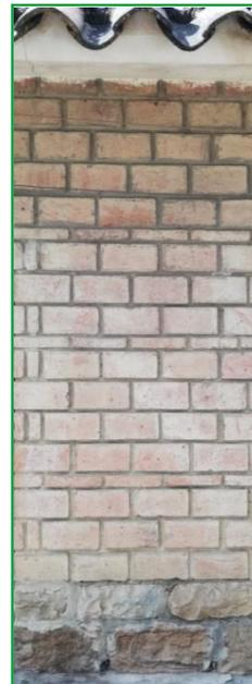
Fotografía N°10: Enchape de ladrillo y zócalo de piedra.
