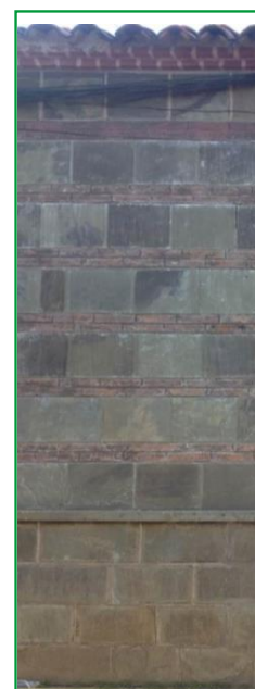
Fotografía N°11: Enchape mixto y zócalo de piedra.
