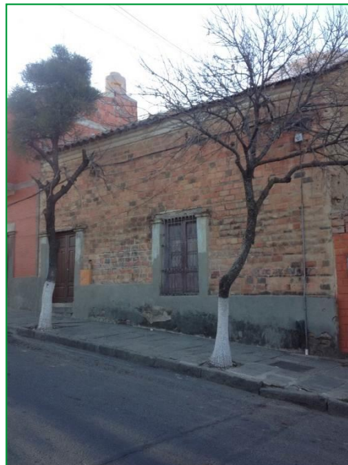
Fotografía N°7: Vivienda con blindaje.
