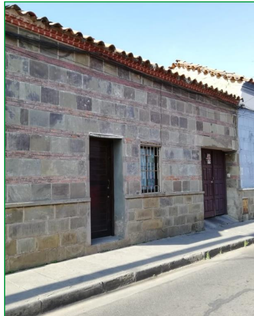
Fotografía N°6: Vivienda con blindaje.
