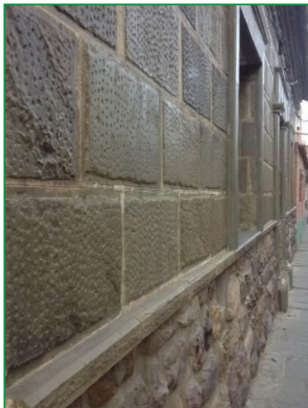
Fotografía N°5: Enchape de piedra.
