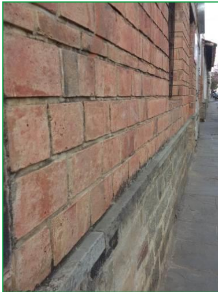
Fotografía N°4: Enchape de ladrillo gambote
