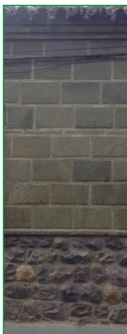
Fotografía N°8: Enchape de piedra y zócalo de piedra.
