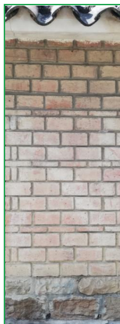
Fotografía N°10: Enchape de ladrillo y zócalo de piedra.
