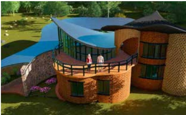
**Descripción técnica:** En cuanto a la construcción y empleo de técnicas para los muros, esta propuesta emplea bloques de tierra comprimida en su totalidad. La mampostería de los muros varía de acuerdo a sectores. Se utiliza una mampostería que deja aberturas en el muro
