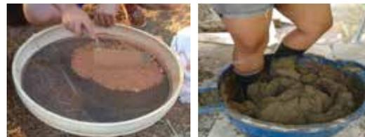
Para un trabajo a detalle ya sea en el interior de la vivienda como ornamento empleando arcilla, se procede al tamizado de la tierra, dando como resultado la separación de partículas de tierra, limo y arcilla.
