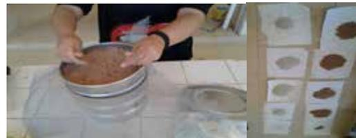
**Disolver barro:** para lograr disolver se debe dejar en remojo por un día para obtener una sustancia moldeable y lista para ser preparada y mezclada con otros aglomerantes.
