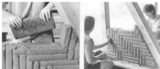
El barro plástico ha sido utilizado por miles de años para rellenar espacios en las viviendas construidas con rollizos donde los maderos se colocan horizontalmente y empalizadas (donde los rollizos se colocan verticalmente). En las viviendas el barro plástico se lanza en una esfera de ramas, gajos y cañas de bambú y otras.
