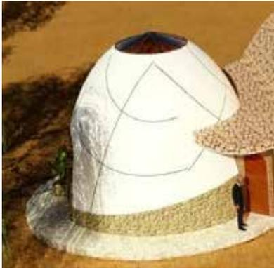
Es un sistema de bajo costo, a base de bloques de tierra comprimida (BTC) o adobe, y no requiere de cimbra ni concreto armado se emplea los bloques generalmente de 5 cm x 10 cm x 20.
