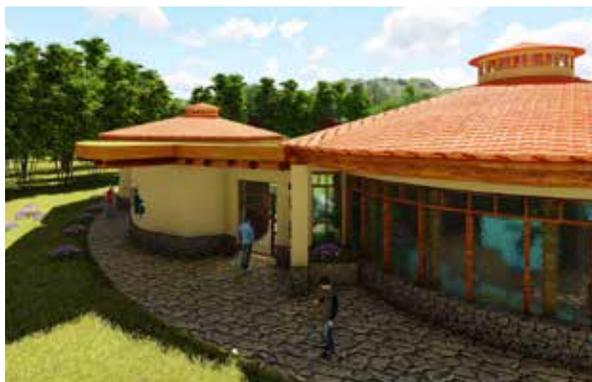
Esta propuesta emplea dos tipos de cubiertas. En los ambientes de dormitorio principal y ambientes compartidos como living, comedor, cocina y de apoyo, utilizan un sistema de cubiertas de estructuras recíprocas. Se escogió este tipo de estructuras que se auto sostienen entre sí, permitiendo grandes luces y aportando de sobremanera al diseño interior.
