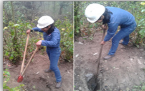
Figura 4: Toma de datos y profundidades de las calicatas
