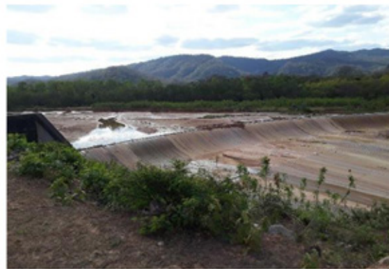
Figura 10 Dique Itiyuro. Vertedero de alivio. Pendientes mínimas 0° a 2°
