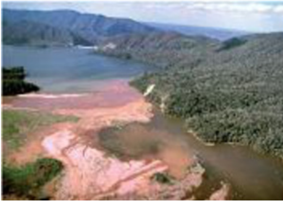
Figura 12. Zona de depositación. Dique Ituyuro.
