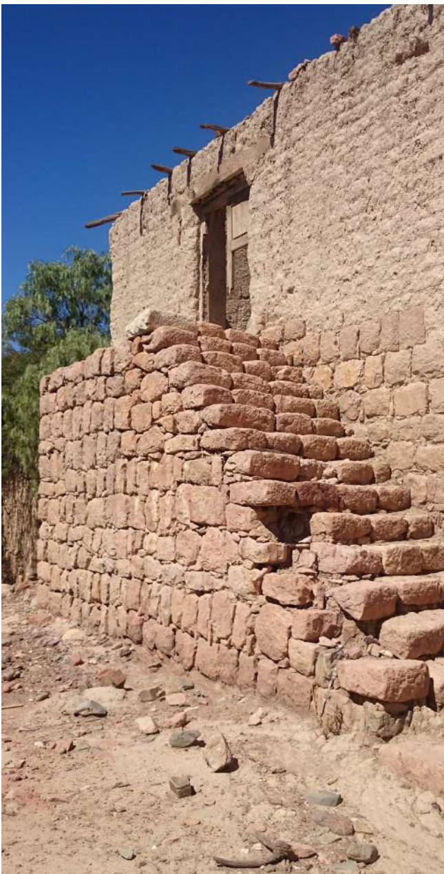
Imagen. 3. Vivienda, Municipio de Camargo. Fuente: Autor
