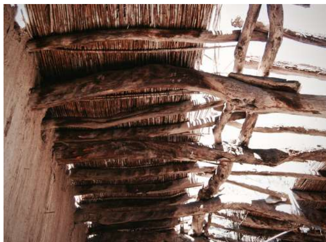
Imag. 6. Materialidad de la cubierta Autor: Mauricio Méndez
