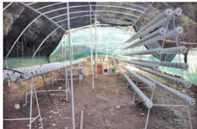
Figura 3. Colocado de las tuberías a los caballetes
