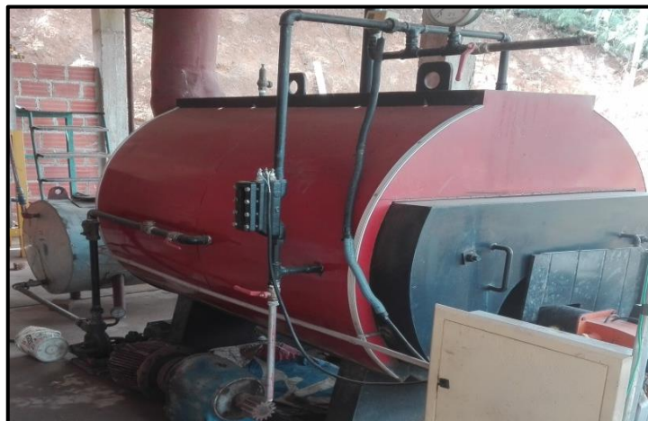
Foto II-18. Caldera horizontal humotubular
