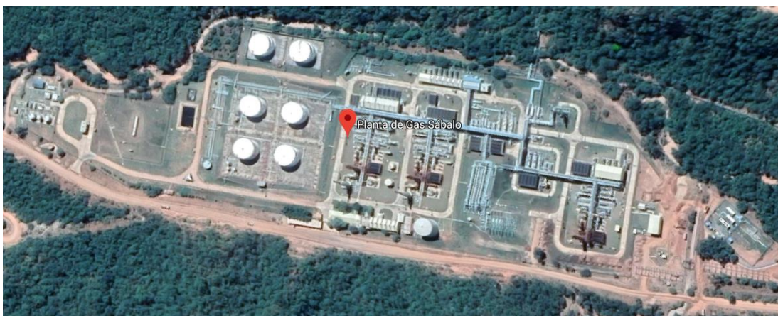
Fig. 1- 7 Localización de la Planta de Gas Sábalo
