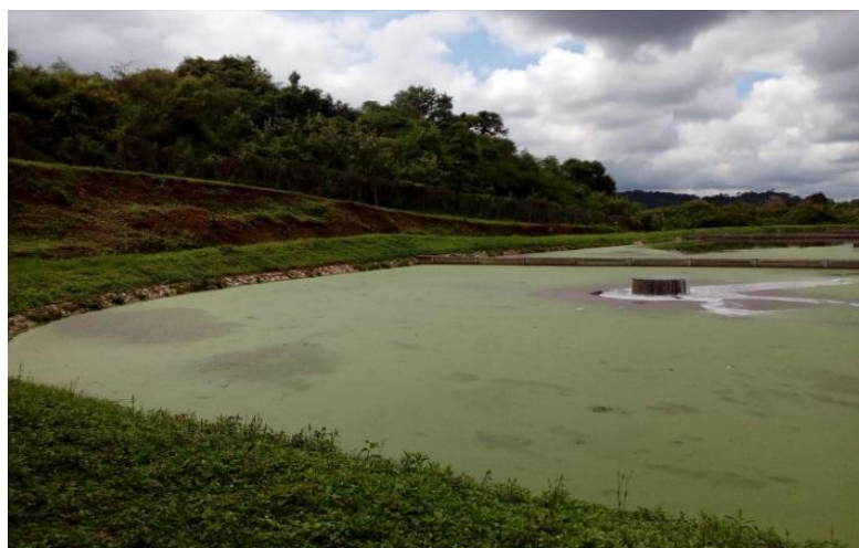
Foto 2-11. Inicio de la Laguna Facultativa. Elaboración Propia
