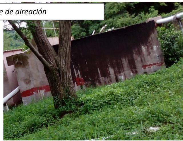
Parte superior del tanque de aireación
