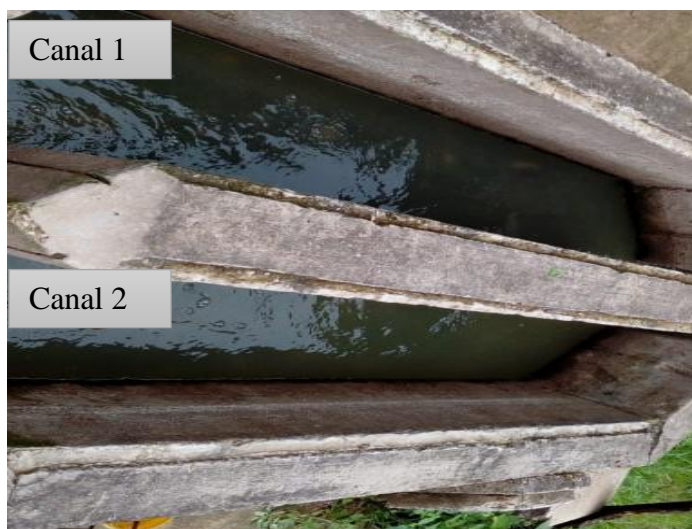
Foto 2-20. Canales paralelos (desarenador). Elaboración Propia
