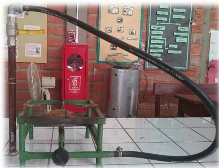
Figura II-6: Cocina pequeña conectada al tubo de gas natural
