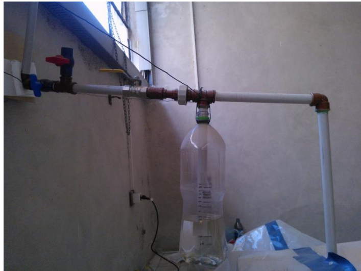
Figura ¡Error! No hay texto con el estilo especificado en el documento. -26 Conducción de biogás y válvula de seguridad.
