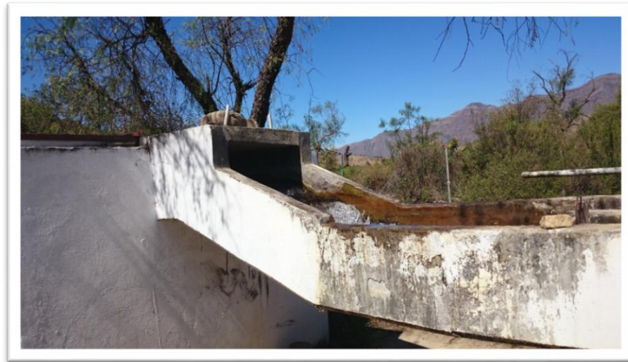
Fig. II-3 Canal Parshall
