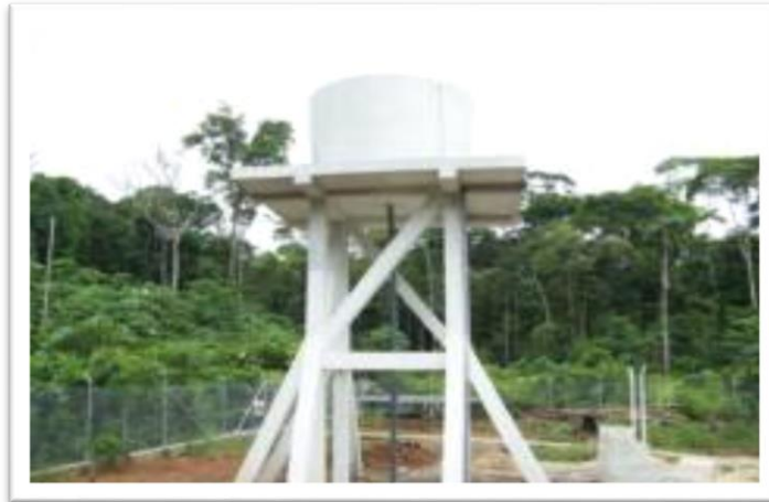
Figura II-10 Tanque de agua elevado
