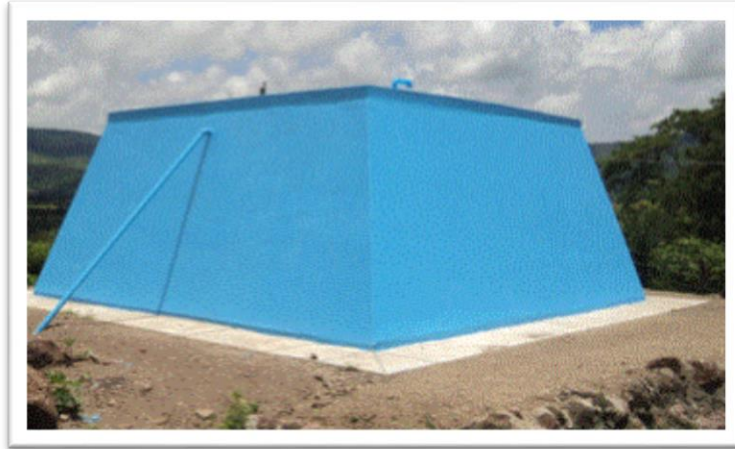
Figura II-9 Tanque de Agua sobre suelo
