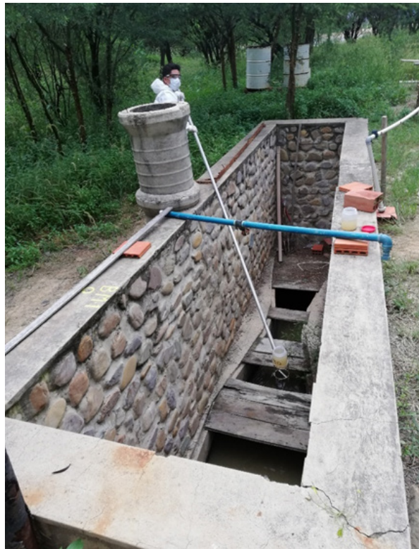
Fotografía 5. Lugar de muestreo Canal Parshall - PTAR San Luis
