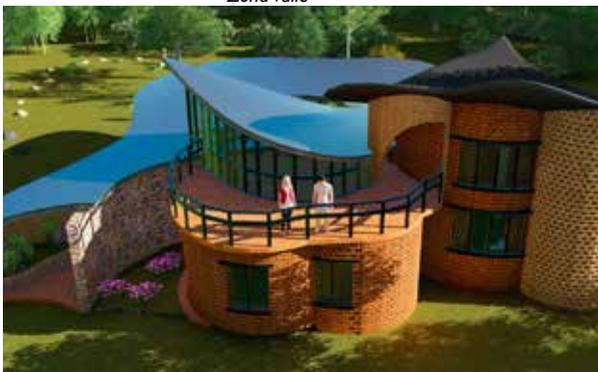
**Descripción técnica:** En cuanto a la construcción y empleo de técnicas para los muros, esta propuesta emplea bloques de tierra comprimida en su totalidad. La mampostería de los muros varía de acuerdo a sectores. Se utiliza una mampostería que deja aberturas en el muro
