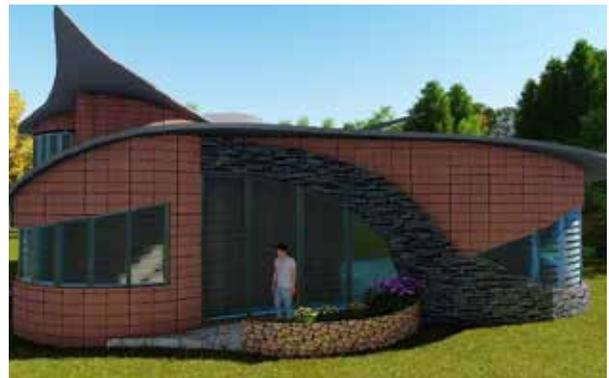
La cubierta a emplear en este diseño es de ferrocemento, la más adecuada para permitirnos jugar con las curvas y pendientes; es una estructura liviana que posibilita el moldeado de la forma.
