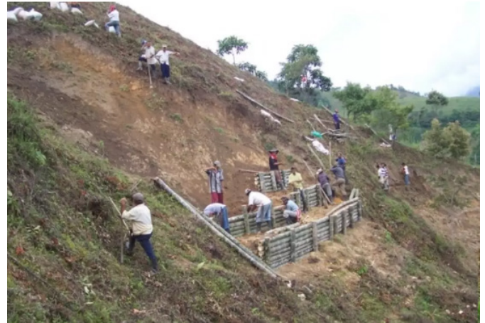
Figura 17. Ejemplo de Obras de Contención para el Manejo de Cuenca
