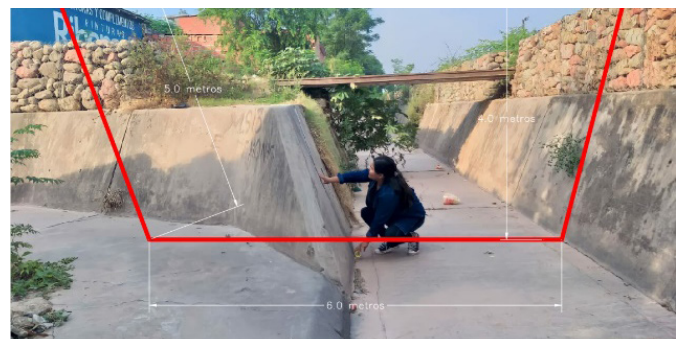
Figura 15. Propuesta de Aumento de Sección en un Canal Crítico, en rojo la sección propuesta
