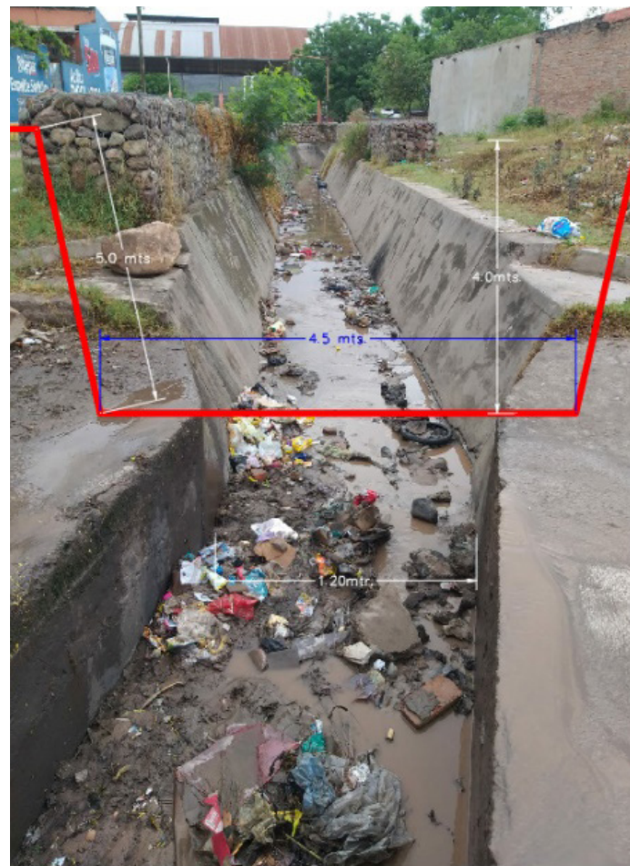
Figura 5. Sección de canal muy reducido
