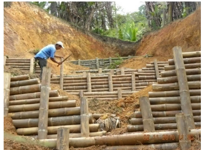
Figura 18. Obras de Contención para el Manejo de Cuenca
