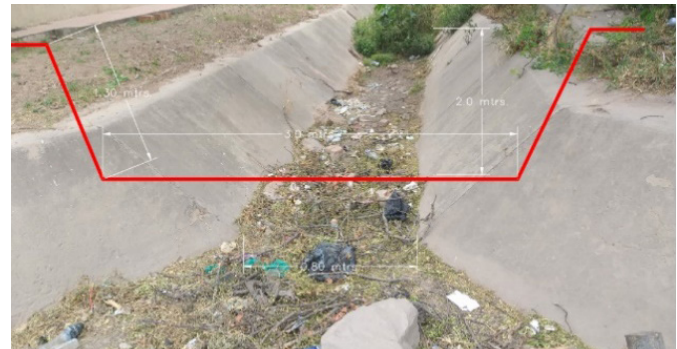
Figura 15. Propuesta de Aumento de Sección en un Canal Crítico, en rojo la sección propuesta
