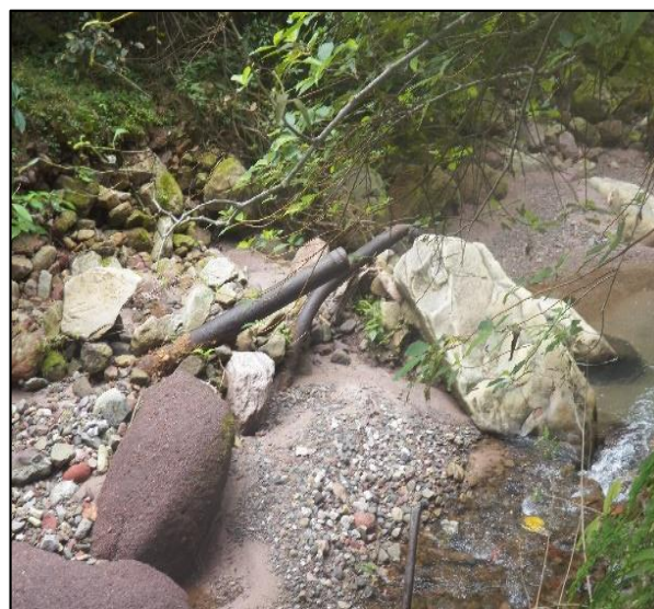
Figura 6. Restos de tuberías metálicas abandonadas sobre el cauce de la quebrada Cororoy.
