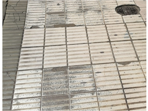
Figura 21: Material usado en acera 2,50 m Calle La Madrid 2022
