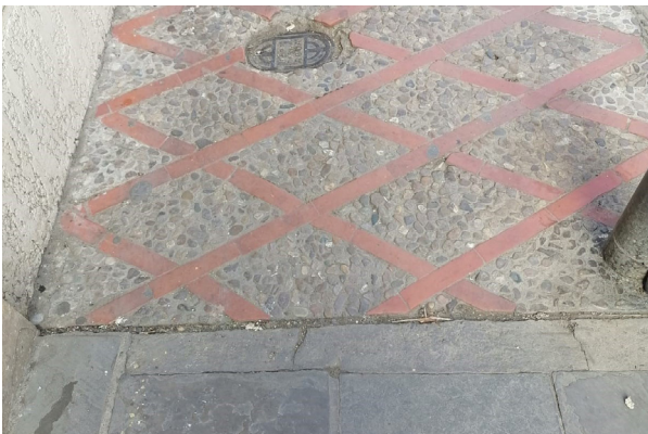
Figura 20: Materiales usados en acera 2,50 m Calle Bolivar 2022
