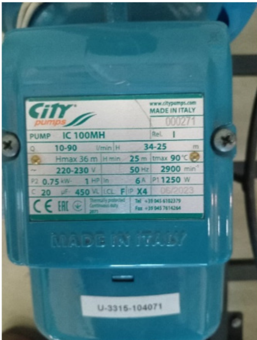
Figura 2: Placa de características técnicas de la Bomba CityPumps IC 100 MH empleada para el sistema de recirculación
